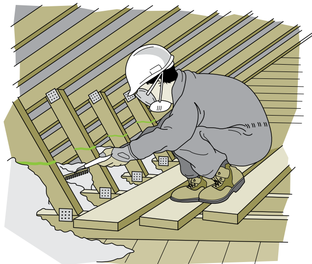
Figure 5-14 Pose de l'isolant en vrac
